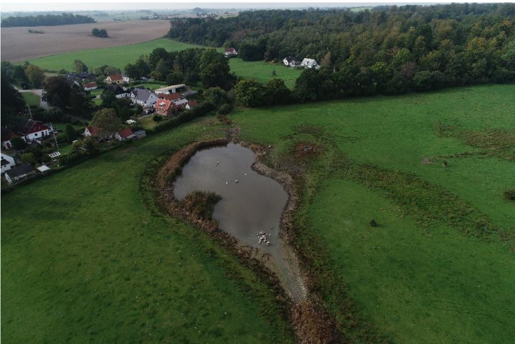
Figur 8 visar översiktliga bilder på Böringe mad. Vid besökstillfället var vattennivån i våtmarken av-sänkt, samtidigt hördes vattenflöde i en avsänkingsmunk som anlagts bredvid det öppna utloppet. Locket på munken var låst, men kontroll av planksättarna i munken krävs, eventuellt har vattenytan tillfälligt aktivt sänkts som en del i en skötselstrategi.
